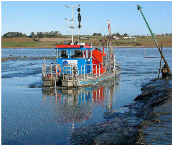
Figure 18 - Exemple d'un curage hydraulique par drague aspiratrice dans l'estuaire de la Vilaine (370 000m 3 IAV)
