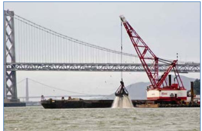
Figure 106 : Curage à l'aide d'une benne preneuse
