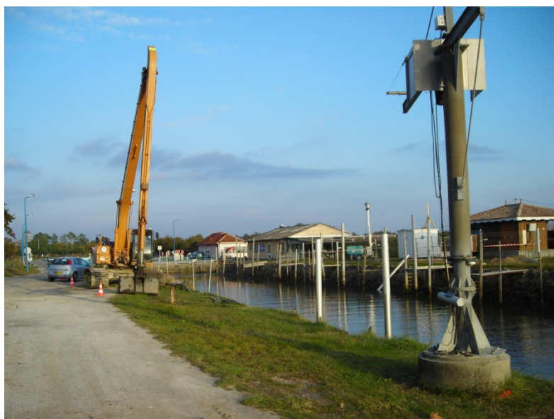
Figure 54 - Pelle bras long pour curage d'appointement (IDRA)
