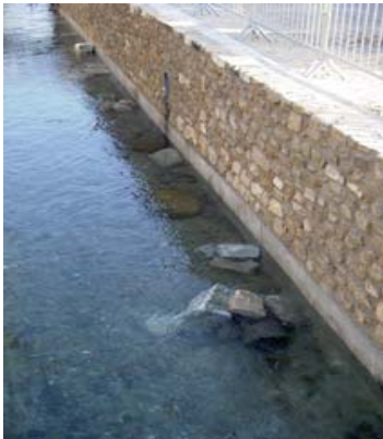
Figure 25 - Berges maçonnées et petits aménagements visant à créer des abris piscicoles (SMBS)
