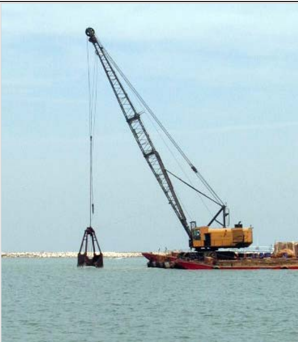
Figure 106 : Curage à l'aide d'une benne preneuse
