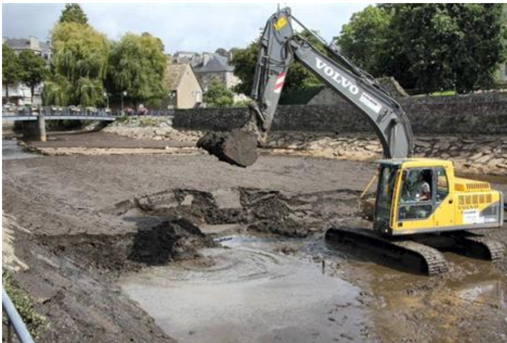
Figure 47 - Exemple de curage mécanique à sec (Ouest France)
