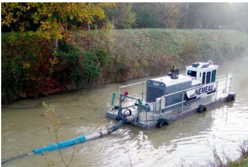
Figure 8- Exemple d'un curage hydraulique par drague aspiratrice en rivière (NEMEAU)
