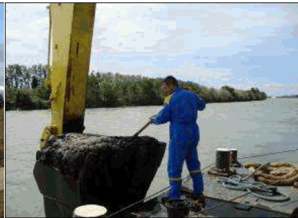
Figure 77 –Pelle sur ponton.
