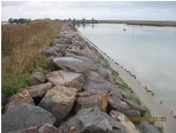
Figure 24 - Protection de digue par la pose d'enrochement (Arcadis)
